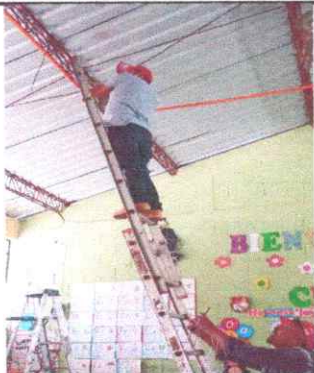
Foto1: Reparación Sistema electrico
