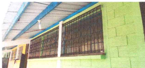
Foto 4: Mejoramiento balcones en laboratorio de computación
