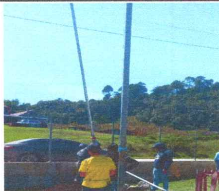
Foto 2: Sustitución de ducto electros y accesorios
