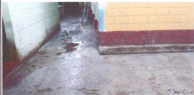
Foto 5: Reparación piso patio
