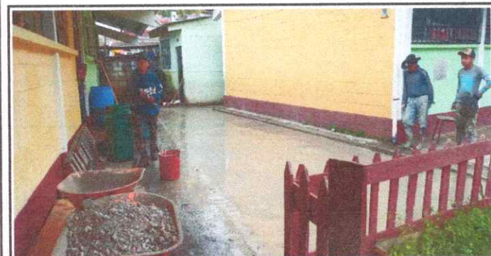
Foto 5: Reparación piso patio
