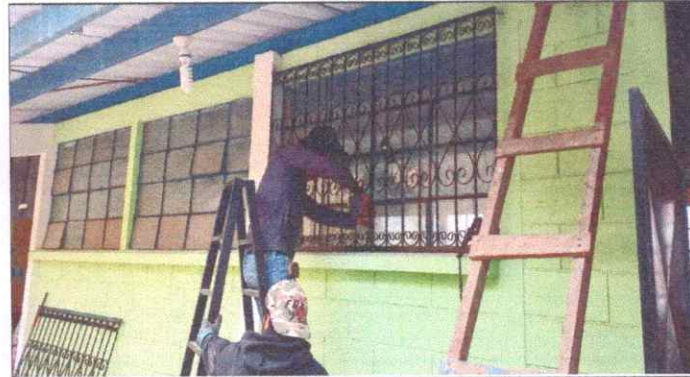
Foto 4: Mejoramiento balcones en laboratorio de computación
