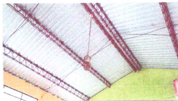
Foto 2: Sustitución de ducto electros y accesorios
