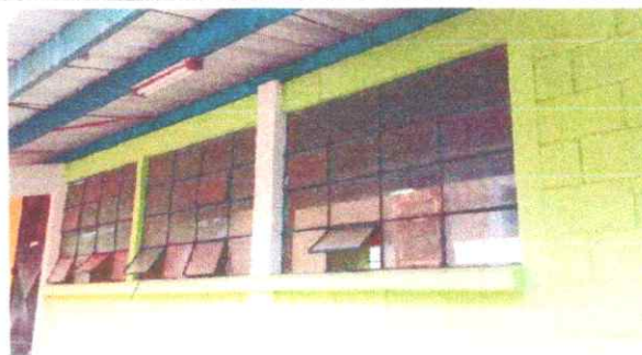
Foto 4: Mejoramiento balcones en laboratorio de computación
