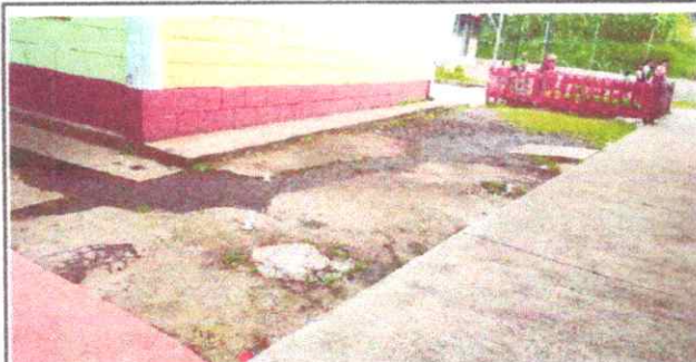
Foto 5: Reparación piso patio
