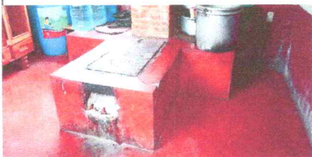
Foto1: Estufa en malas condiciones
