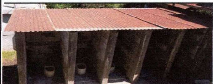
Foto1: Sustitución de lámina por lámina troquelada
