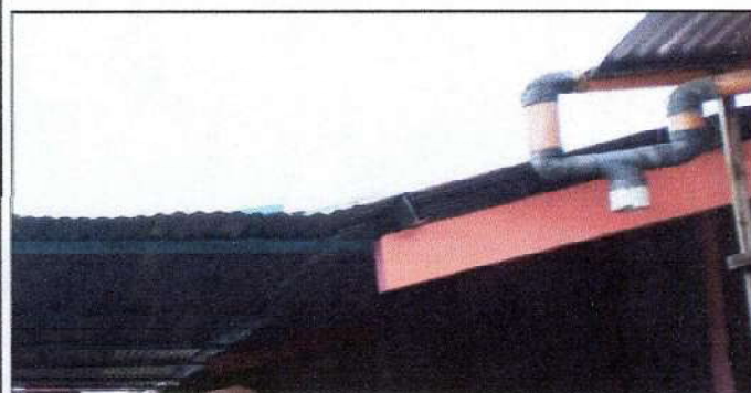
Foto 5: Canales y bajadas de agua
