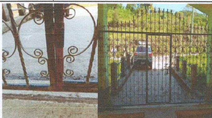
Mantenimiento de portón
