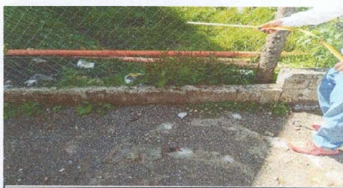
Foto 5: Reparación de tubo hg y malla galvanizada
