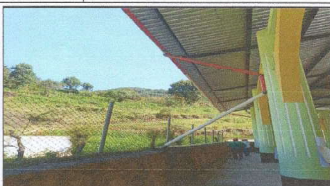
Foto 2: Sustitución por canal de metal
