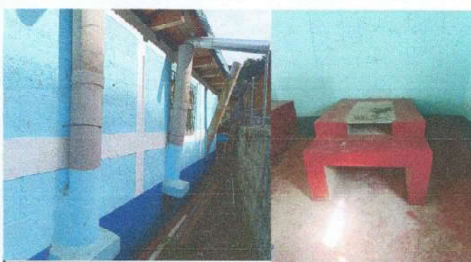
Foto 6: Pila de cocina, lavadero y chimeneas
