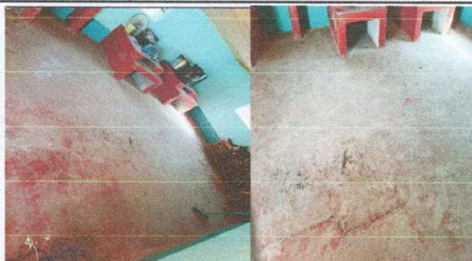
Sustitución de piso a granito
