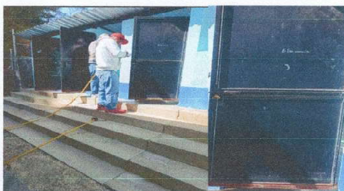
Mantenimiento de puerta de metal
