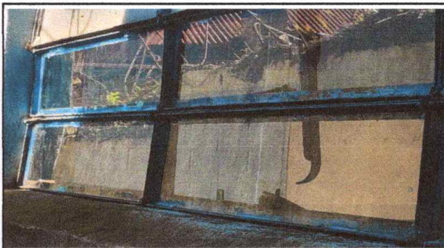
Foto 4: Mantenimiento de ventana
