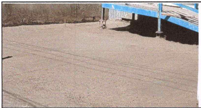
Foto 5: Reparación de planchas de concreto de patio
