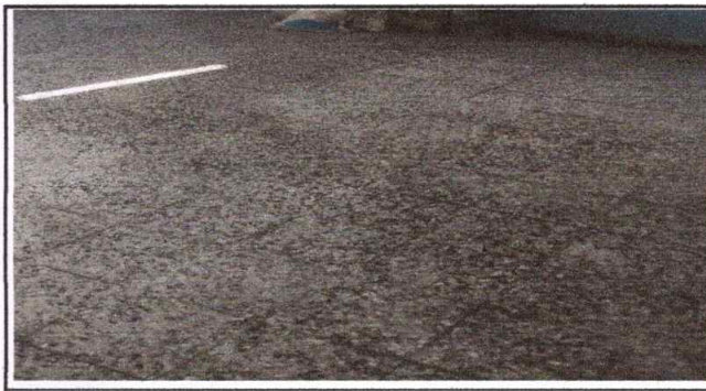
Foto 6: Piso de concreto
