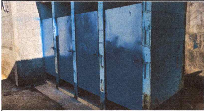
Foto 1: Mantenimiento a estructura de puerta
