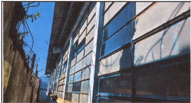
Foto 3: Sustitucion de vidrios
