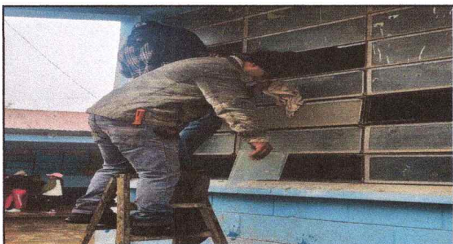
Foto 3: Sustitución de vidrios
