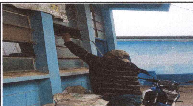
Foto 4: Mantenimiento de ventana
