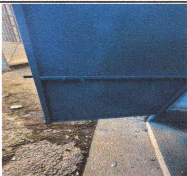
Foto 1: Mantenimiento a estructura de puerta
