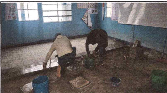
Foto 6: Piso de concreto
