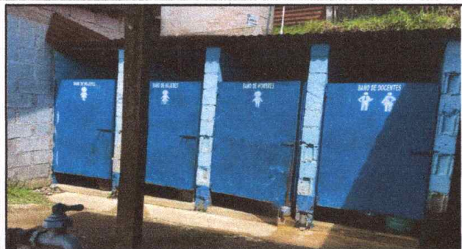
Foto 1: Mantenimiento a estructura de puerta
