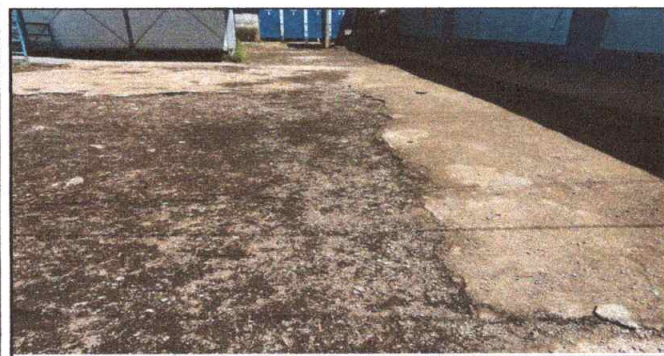
Foto 5: Reparación de planchas de concreto de patio
