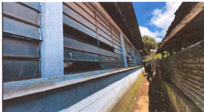
Foto 4: Mantenimiento de ventana
