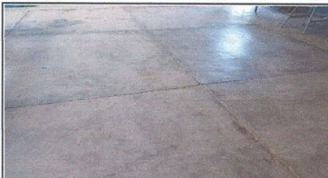
Foto 3: Sustitución de piso de cemento a piso de granito en aulas.
