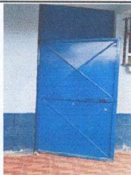
Foto 1: Mantenimiento de puertas de aulas.
