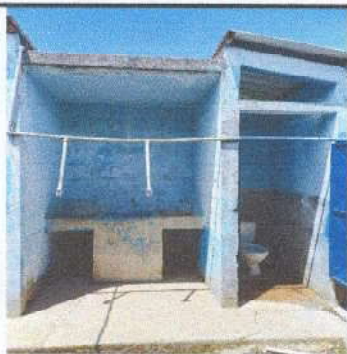
Foto 5: Deterioro y filtración de agua por desnivel en sanitarios
