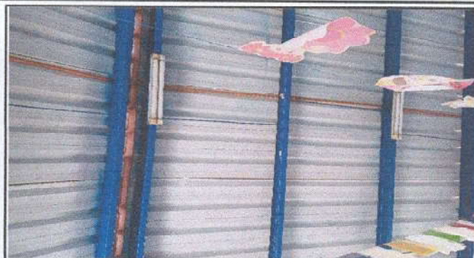
Foto 7: Sustrucción de cableado de electricidad.
