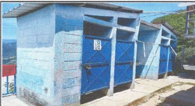
Foto 2: Mantenimiento de puertas de servicios sanitarios.
