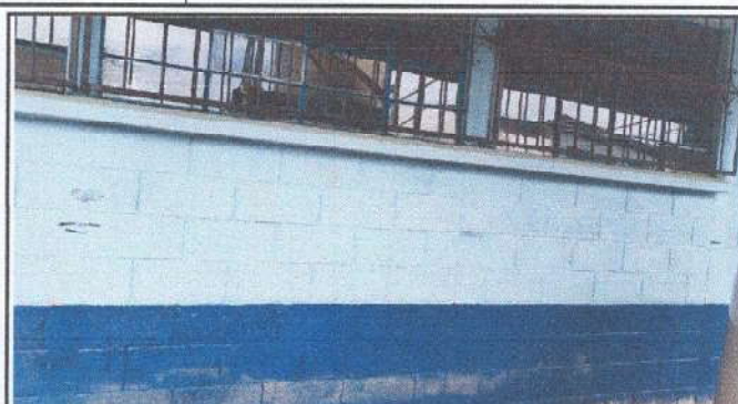
Foto 8: Pintura de interiores y exteriores de aulas
