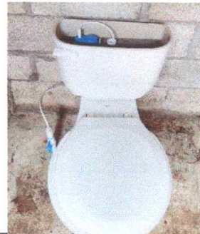
Foto 6: Sustrución de accesorios inodoro (contra llave, tubo de abasto y tanque)
