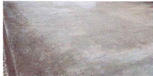
Foto 4: Sustrución de piso de torta de concreto
