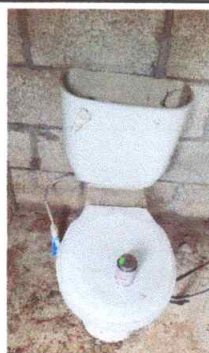
Foto 6: Sustitución de accesorios inodoro (contra llave, tubo de abasto y tanque)
