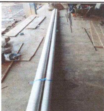
Foto 5: Reparación de bajada de agua pluvial, tubo PVC 3"
