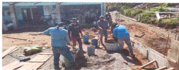
Foto 4: Sustitución de piso de torta de concreto
