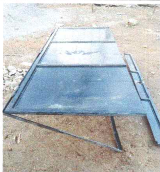
Foto 3: Sustitución de puerta (2.10m de alto * 1.00m de ancho)
