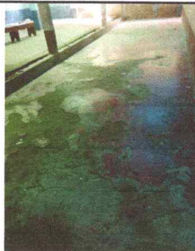
Foto 4: Sustitución de piso de torta de concreto
