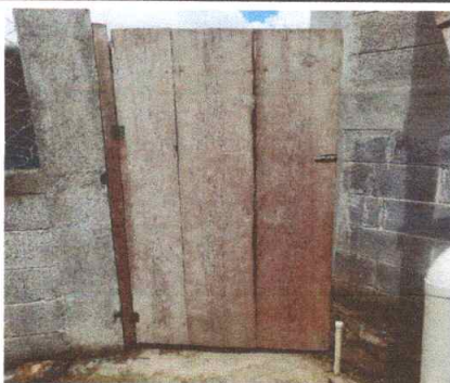
Foto 3: Sustitución de puerta (2.10m de alto * 1.00m de ancho)
