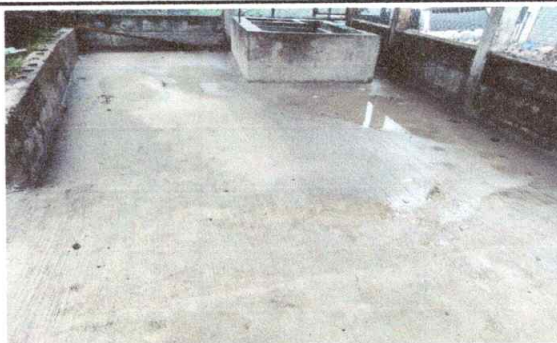
Foto 5: Imagen del piso de la pila terminado
