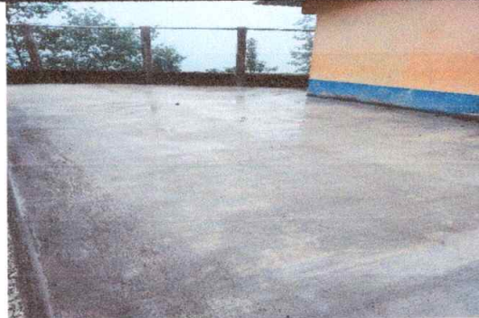
Foto 2: Piso del patio terminado
