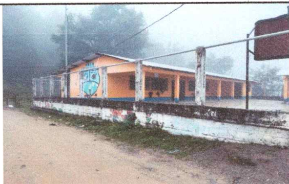
Foto 3: malla totalmente nueva en la parte frontal
