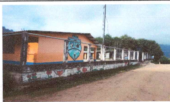
Foto 4: Malla perimetral completamente nuevo y terminado
