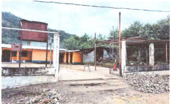
Foto1: Preparando el area para colocar el porton corredizo
