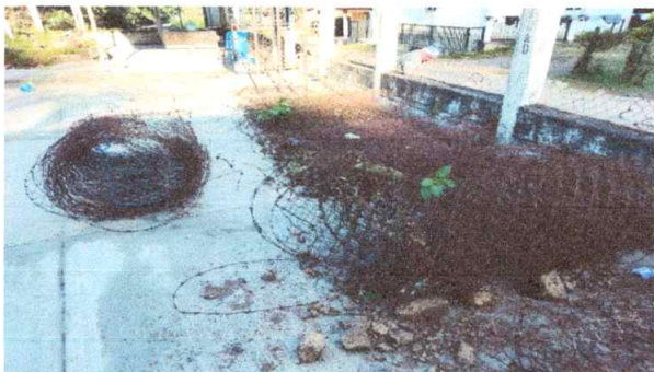
Foto 3: Preparando el area para colocar la nueva malla galvanizada
