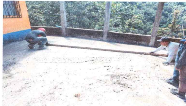
Foto 2: Colocación del piso al final del patio
