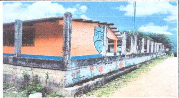
Foto 4: cambio de malla del perimetro total del centro ecuativo por deterioro
