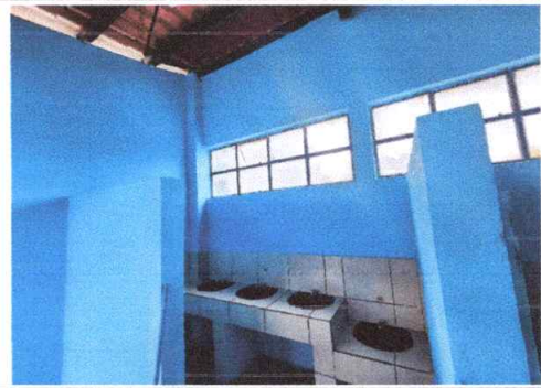
Foto 8: Pintura en interiores y exteriores de sanitarios
