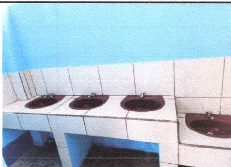
Foto 5: Sustitución de mezcladora lavamanos ( Llave para lavamanos)
