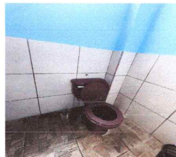
Foto 4: Sustitución de accesorios inodoro (Tanque)
