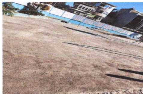
Foto 2: Reconstrucción de loza de patio
