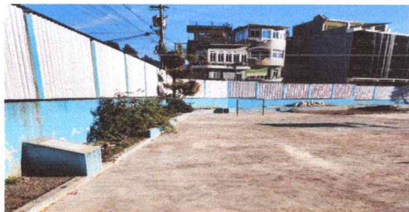
Foto 1: Reconstrucción de loza de patio.
