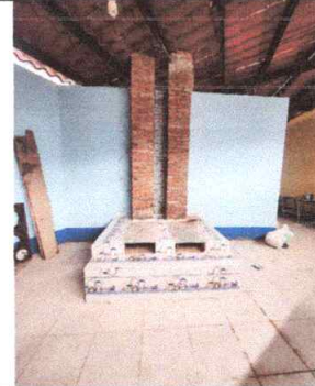
Foto 10: Sustitución y ampliación de estufa rural a estufa de 2 planchas (Completa)
