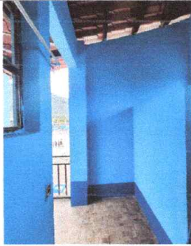
Foto7: Pintura en interiores y exteriores de sanitarios
