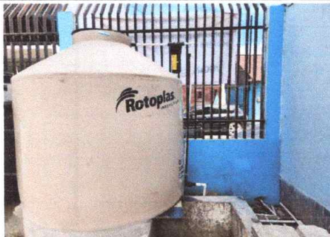
Foto 11: Sustitución de depósito de agua 2500 lt
