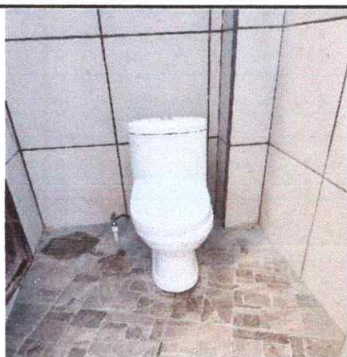
Foto 3: Sustitución de inodoro
