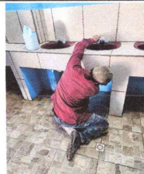
Foto 6: Sustitución de mezcladora lavamanos (Llave para lavamanos)
