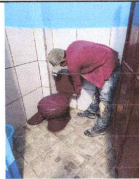
Foto 4: Sustitución de accesorios inodoro (Tanque)
