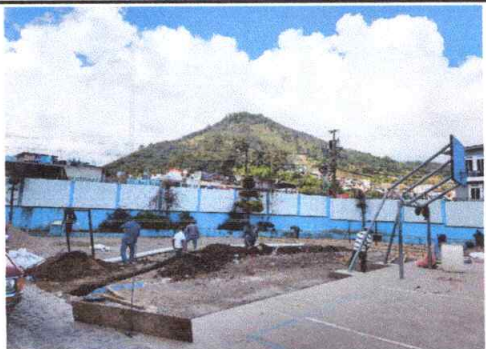
Foto1: Reconstrucción de loza de patio.
