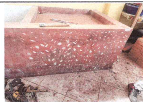
Foto 12: Instalación de azulejo en el exterior de pila de cocina
