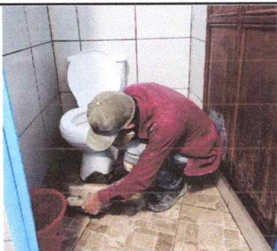
Foto 3: Sustitución de inodoro
