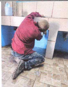
Foto 5: Sustitución de mezcladora lavamanos (Llave para lavamanos)
