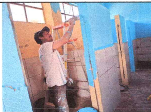
Foto 8: Pintura en Interiores y exteriores de sanitarios
