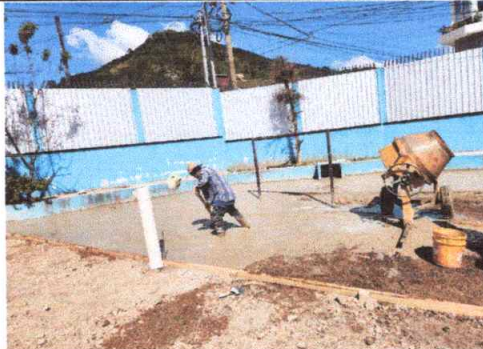
Foto 2: Reconstrucción de loza de patio.
