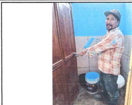
Foto7: Pintura en Interiores y exteriores de sanitarios
