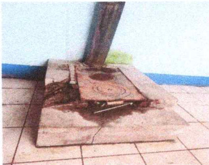
Foto 9: Sustitución y ampliación de estufa rural a estufa de 2 planchas (Completa)
