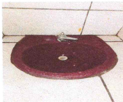
Foto 6: Sustitución de mezcladora lavamanos (Llave para lavamanos)
