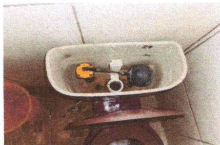
Foto 4: Sustitución de accesorios inodoro (Tanque)
