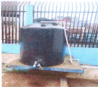
Foto 11: Sustitución de depósito de agua 2500 lt
