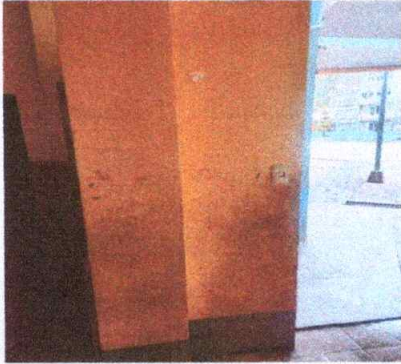
Foto7: Pintura en Interiores y exteriores de sanitarios
