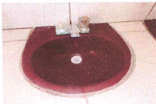
Foto 5: Sustitución de mezcladora lavamanos (Llave para lavamanos)
