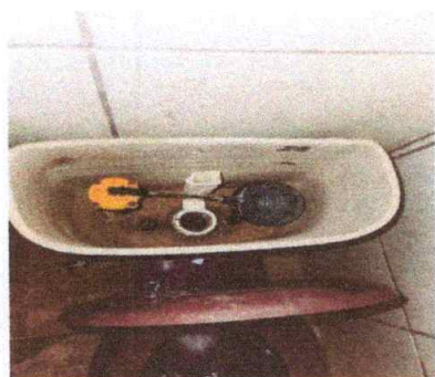
Foto 3: Sustitución de inodoro
