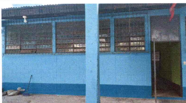
Foto 4: Pintura en muros exteriores e interiores
