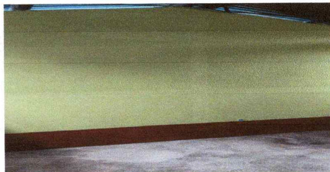
Foto 6: Repello en muro
