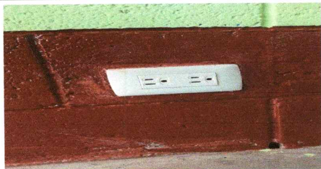
Foto 5: Sustitución de tomacorrientes dobles
