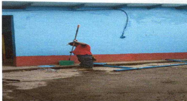
Foto 4: Pintura en muros exteriores e interiores
