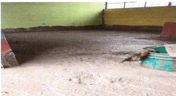
Foto 3: Sustitución de piso de torta de concreto
