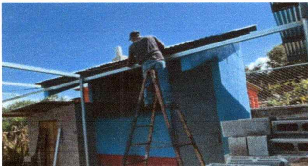
Foto1: Sustitución de lámina, por lámina troqueada alucinc calibre 26
