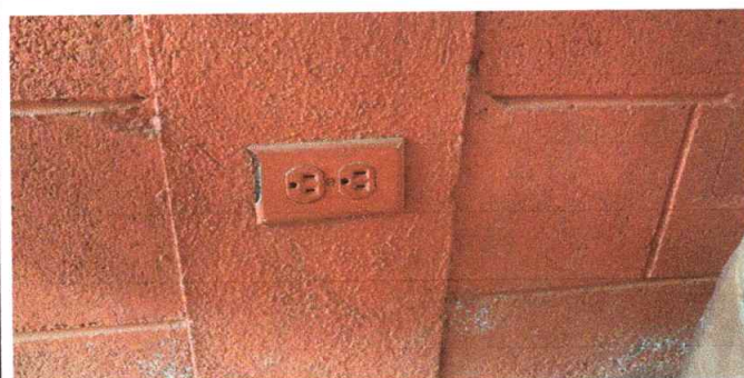
Foto 5: Sustitución de tomacorrientes dobles
