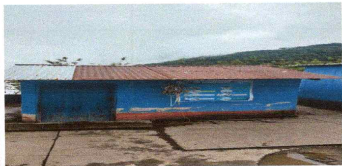
Foto 1: Sustitución de lámina, por lámina troqueada alucinc calibre 26
