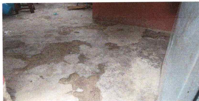
Foto 3: Sustitución de piso de torta de concreto
