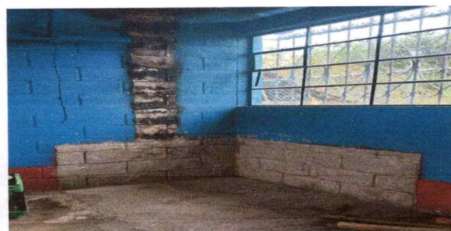
Foto 6: Repello en muro
