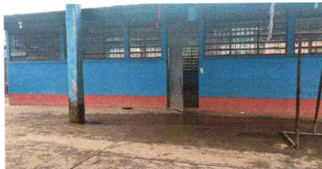
Foto 4: Pintura en muros exteriores e interiores
