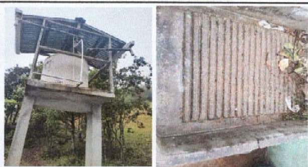
Foto 5: cambio de rotoplas debido a que ya no funciona y una pila motivos de filtración de agua.
