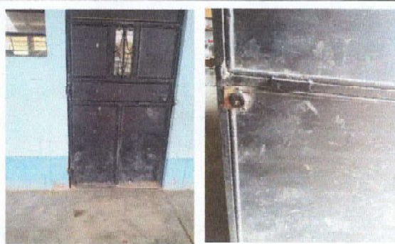
Foto 2: cambio de chapas y pintura de las puertas.
