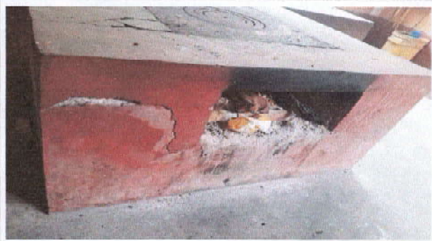
Foto 1: reparación de la parte frontal de la plancha debido a su uso constante.
