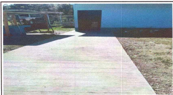
Foto 3: terminación de patio
