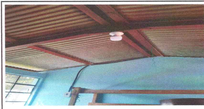
Foto 6: instalación de foco
