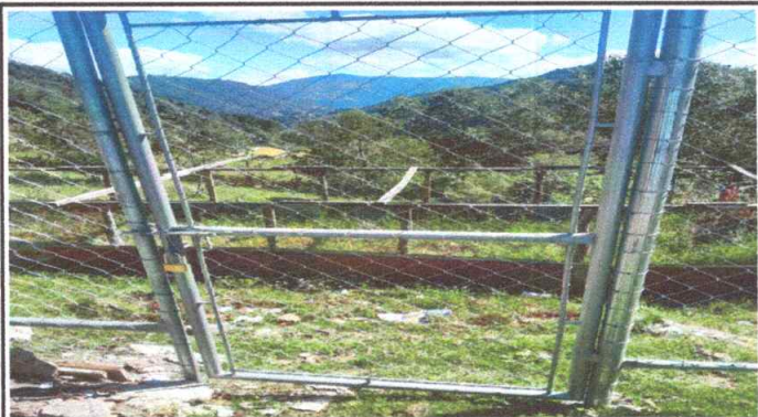
Foto 1: Colocación de puerta de malla
