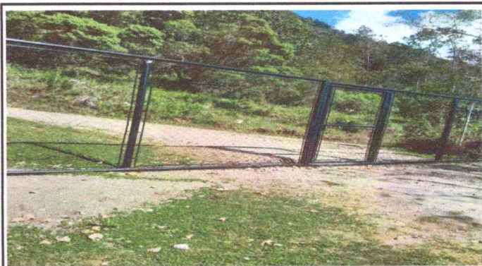
Foto 4: pintura de malla
