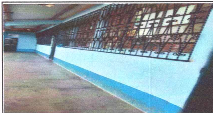
Foto 5: instalación de balcones
