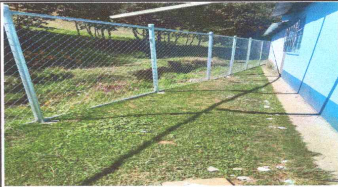
Foto 2: instalación de malla
