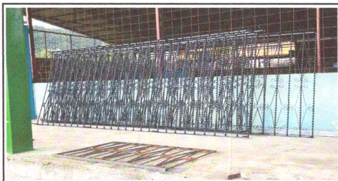
Foto 5: Pintura de balcones
