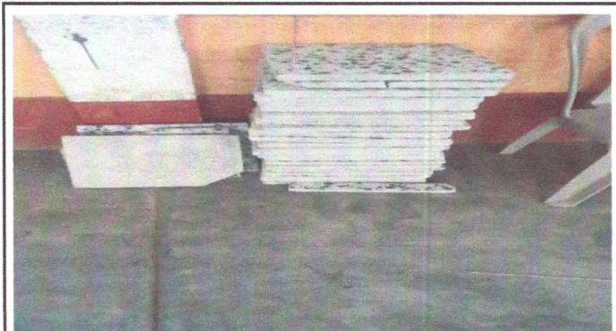
Foto 3: Instalación de cerámico de granito
