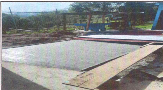
Foto 2: Pavimentación de un área
