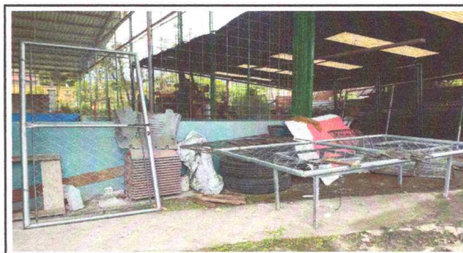
Foto 6: Reparación de puerta y malla
