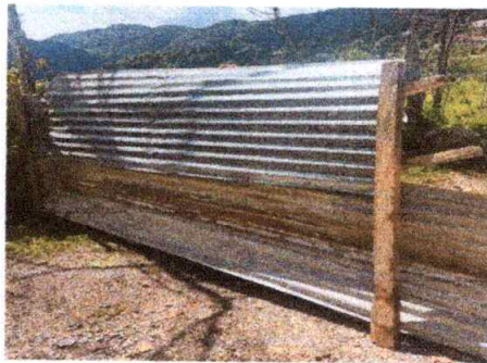
Foto 3: Sustrución de porton de metal
