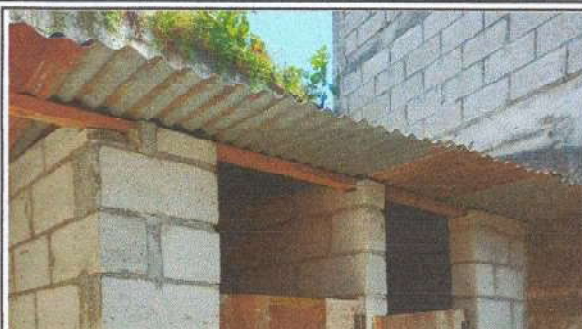
Foto 2: Cambio de elementos de fijación de techo
