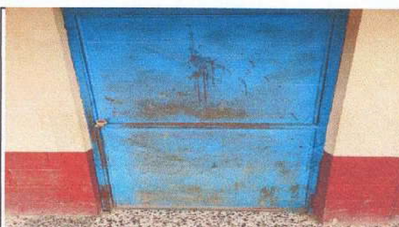
Foto 4: Mantenimiento de puertas
