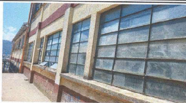
Foto 8: Instalacion de valcones para seguridad en ventanas
