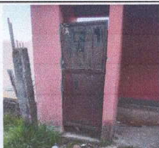
Foto 1: Mantenimiento a estructura de puertas
