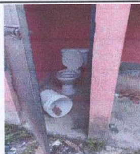
Foto 4: Sustitución de piso de granito
