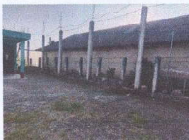
Foto 3: Sustitución de tubo HG y Malla Galvanizada
