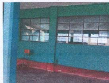
Foto 2: Pintura en muros interiores y exteriores de aulas
