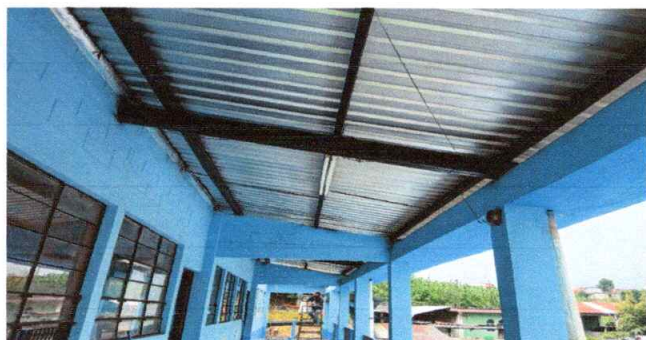
Foto 15. Terminación de mantenimiento a estructura de soporte metal
