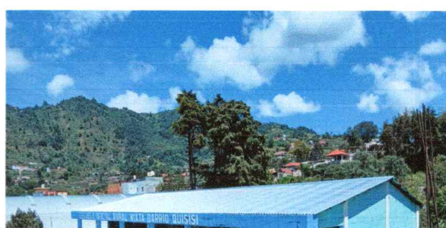
Foto 2: Terminación de sustitución de capote de lámina para lámina troquelada
