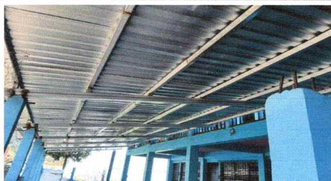
Foto 16. Terminación de Sustitución de soporte de madera por metal
