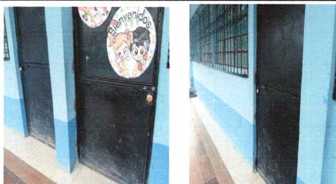
Foto 4: Terminación de sustitución de chapas
