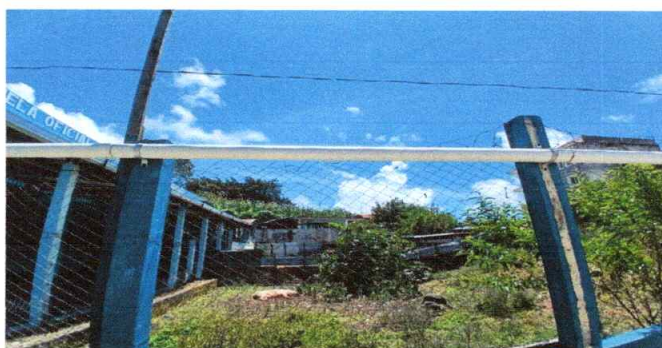
Foto 10: culminación de sustitución de de soporte o pescante de pvc para canal
