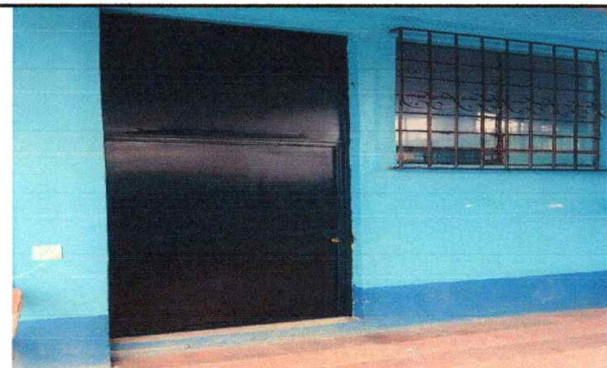
Foto 3: Terminación de trabajo de mantenimiento a estructura (lijado, cambio de tubo cepillado, sujeciones aplicación de pintura
