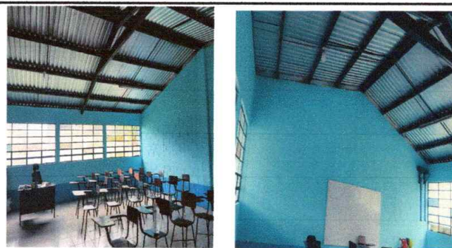
Foto 12: Terminación de aplicación de pintura en muros interiores
