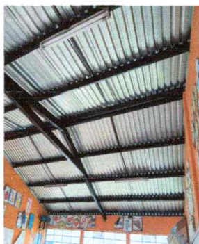
Foto 1: Terminación de la Sustitución de lámina por lámina troquelada
