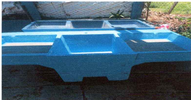
Foto 13: Terminación de sustitución de pila de cemento de dos lavaderos
