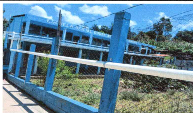
Foto 8: culminación de sustitución de bajada de agua pluvial, tubo PVC de 4 pulgadas
