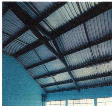
Foto 1: Terminación de la Sustitución de lámina por lámina troquelada
