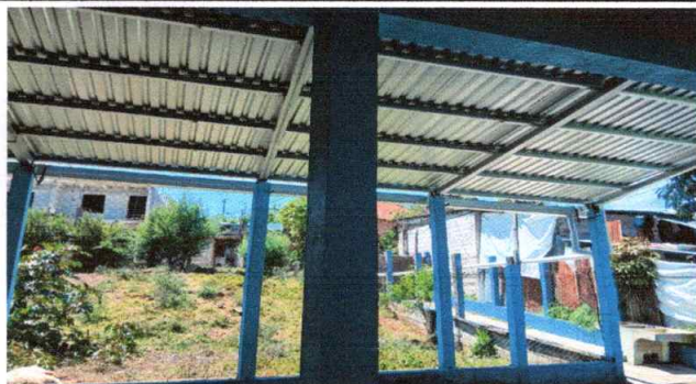
Foto7: Culminación de Sustitución de canal de metal
