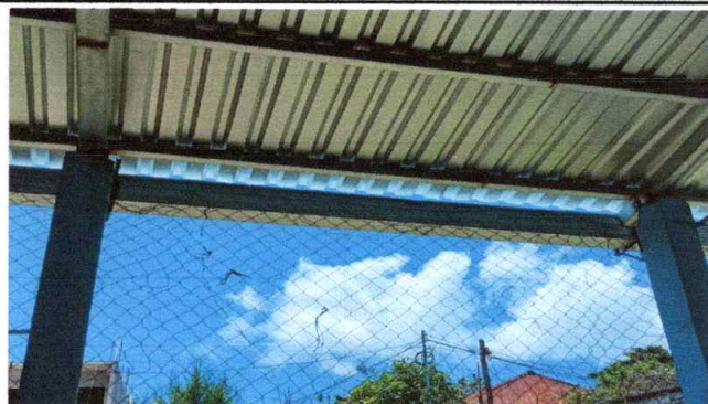
Foto 9: Culminación sustitución de soporte o pescante de metal para canal
