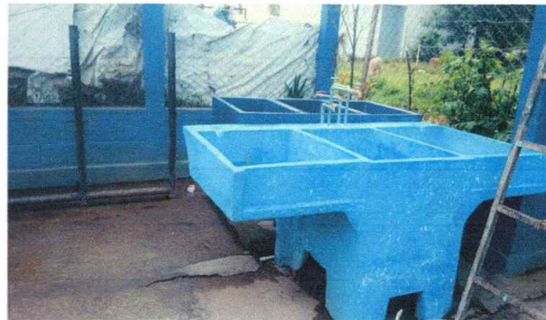
Foto 14: Terminación de sustitución de pila de plástico de dos lavaderos
