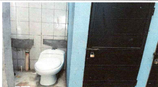
Foto 17. Terminación de Sustitución de inodoro
