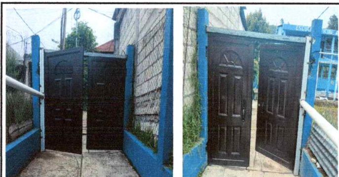
Foto 5: Terminación de sustitución de portón
