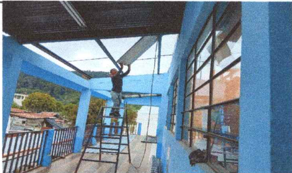
Foto 1: Trabajando la Sustitución de lámina por lámina troquelada
