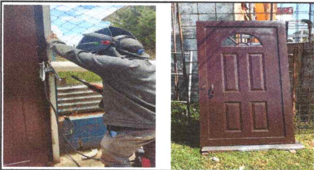
Foto 5: Realizando sustitución de portón
