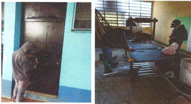
Foto 3: realizando trabajo de mantenimiento a estructura (lijado, cambio de tubo cepillado, sujeciones aplicación de pintura
