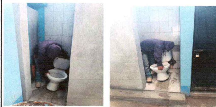
17. Cambiando Sustitución de inodoro
