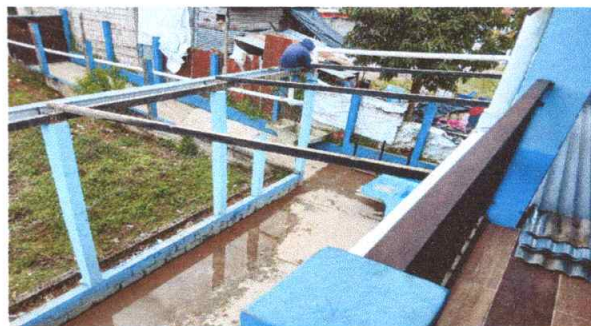
16. Trabajando de Sustitución de estructura de soporte de metal por madera
