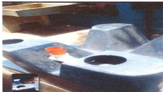
Foto 14: Cambiando sustitución de pila de plástico de dos lavaderos
