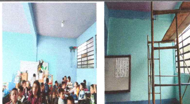
Foto 12: Aplicando pintura en muros interiores
