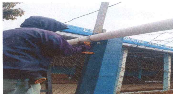
Foto 10: Realizando sustitución de de soporte o pescante de pvc para canal
