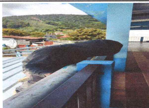
Foto 8: Realizando sustitución de bajada de agua pluvial, tubo PVC de 4 pulgadas
