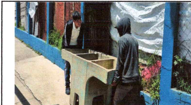
Foto 13: Cambiando sustitución de pila de cemento de dos lavaderos
