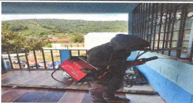
Foto 6: realizando sustitución de balcones de metal
