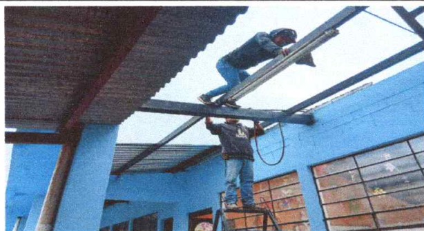
Foto 15: Trabajando de mantenimiento a estructura de soporte de metal
