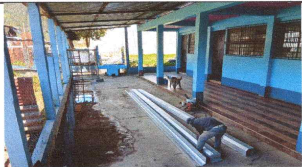
Foto7: Realizando Sustitución de canal de metal
