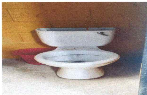
Foto 11. Cambiando sustitución inodoro
