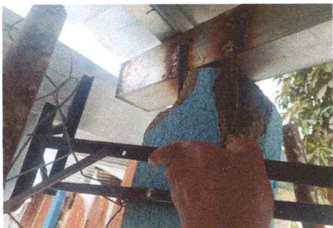
Foto 9: Realizando sustitución de soporte o pescante de metal para canal
