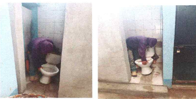
17. Cambiando Sustitución de inodoro
