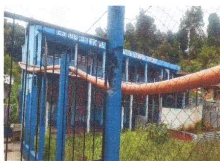
Foto 8: sustitución de bajada de agua pluvial, tubo PVC de 4 pulgadas
