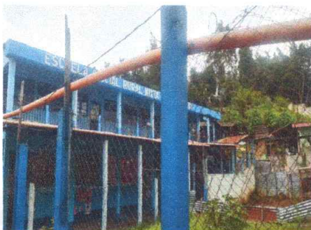
Foto7: Sustitución de canal de metal
