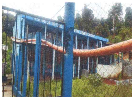
Foto 10: sustitución de de soporte o pescante de pvc para canal
