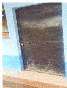
Foto 4: sustitución de chapas
