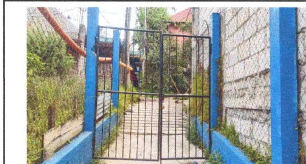
Foto 5: sustitución de portón
