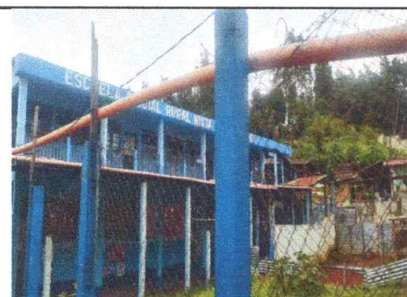
Foto 9: sustitución de soporte o pescante de metal para canal
