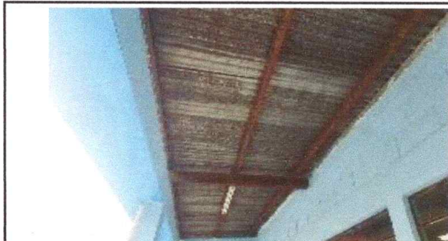
Foto1: Sustitución de lámina por lámina troquelada
