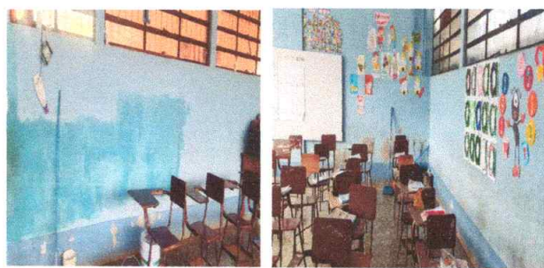
Foto 12: pintura en muros interiores
