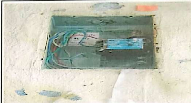
Foto 20: FLIPON DETERIORADO.
