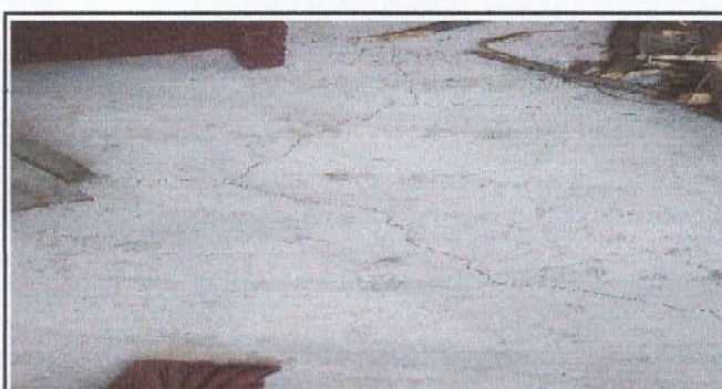
Foto 6: Sustitución de piso
