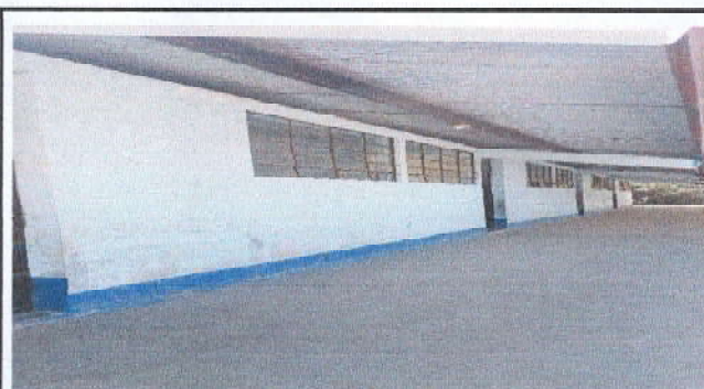
Foto 8: Pintura en muros exteriores
