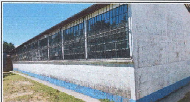
Foto1: Pintura en muros exteriores e interiores
