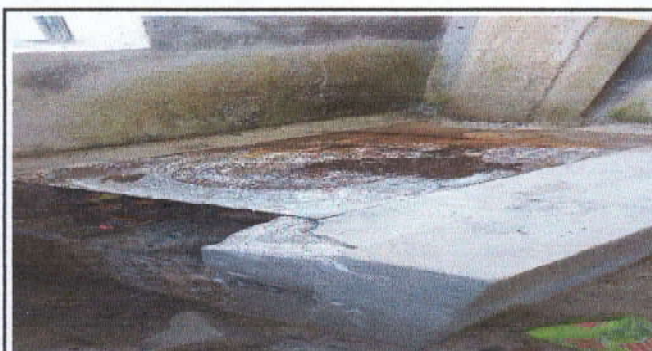
Foto 4: Mantenimiento de estufa rural
