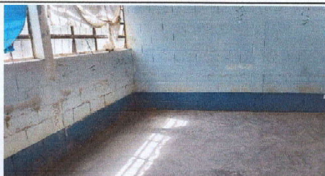
Foto 9: Mejoramiento de repello y cernido de paredes
