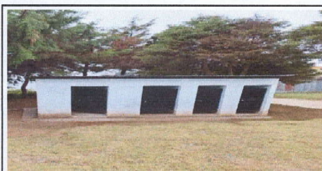
Foto 5: Mantenimiento a estructura de puertas
