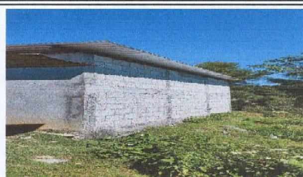
Foto 2: Mejoramiento de repello y cernido de paredes
