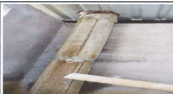
Foto 10: Mantenimiento de estufa rural
