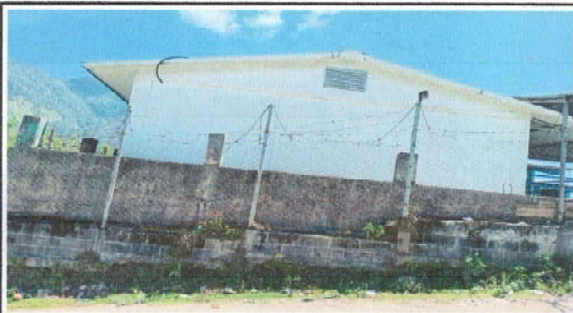
Foto 3: Cerco de malla remplazo y refuerzo
