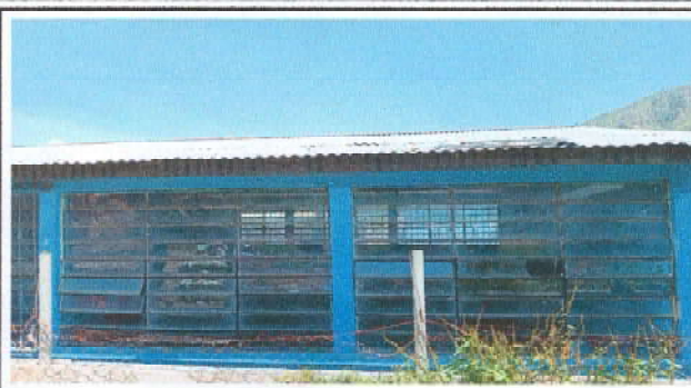
Foto 2: Sustitución de vidrios
