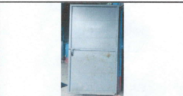
Foto 6: Mantenimiento a estructura de puertas de aulas
