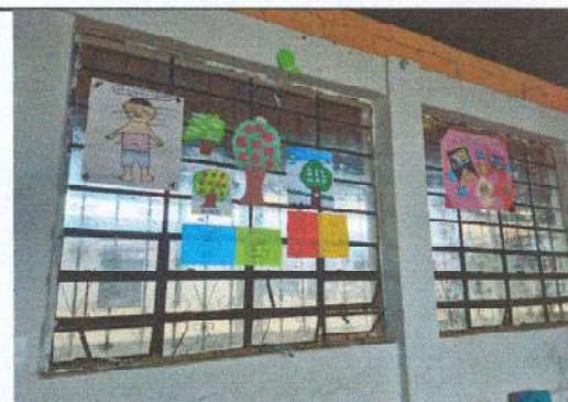
Foto 4: Sustitución de vidrios (28 unidades de vidrios de 35*25cm y 22 de 30*25cm)
