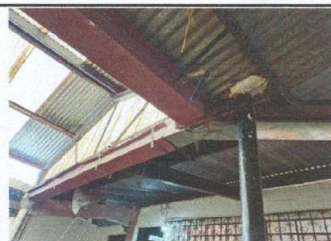
Foto 6 Sustitución de canal de metal (Se instalan canales galvanizados, calibre 26)
