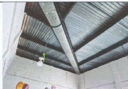
Foto 3: Mantenimiento a estructura de soporte de metal (Se le aplicará lijado, pintura con soplete a la estructura del techo)
