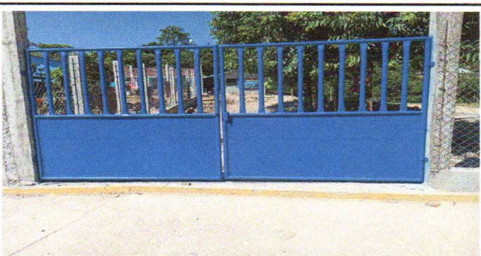
Foto 6: Sustitución de un portón.
