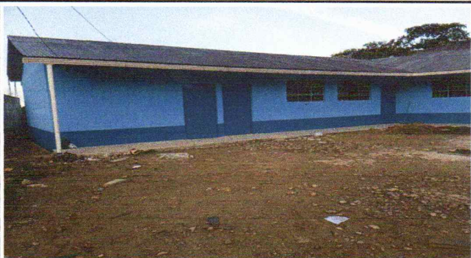
Foto 3: Aplicación de pintura de interior y exterior.
