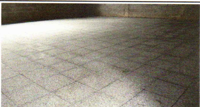
Foto 2: Sustitución de piso de granito.
