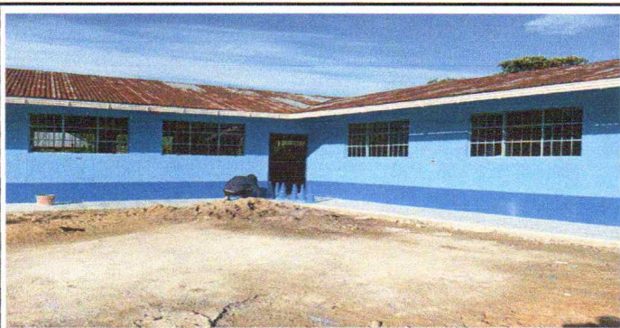
Foto 5: Sustitución de vidrios.
