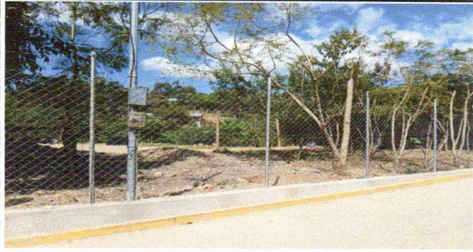
Foto1: Sustitución de postes de madera por tubos HG y malla galvanizada M2.(Suatitución de muro perimetral)
