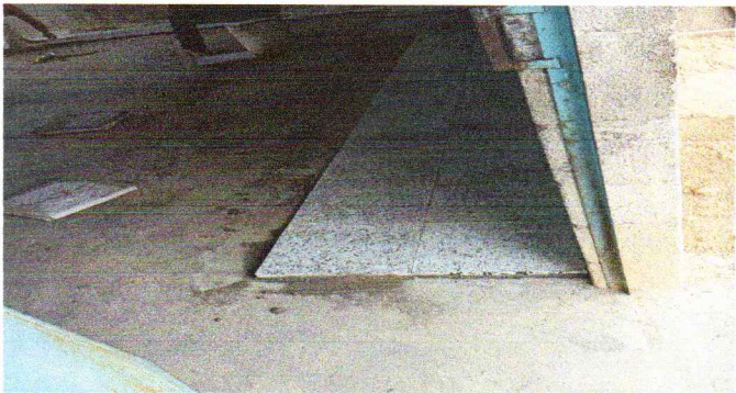
Foto 2: Sustitución de piso de granito.
