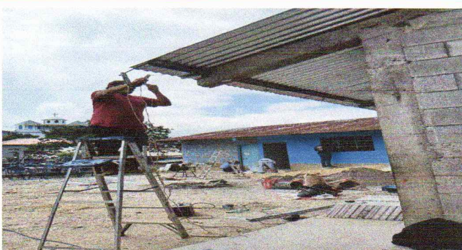
Foto 4: Sustitución de capotes de Aluzin de 2 metros de largo.
