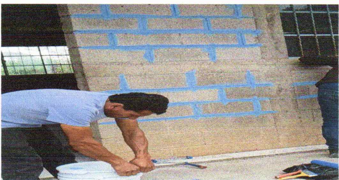
Foto 3: Aplicación de pintura de interior y exterior.
