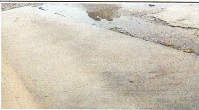
Foto 2: Sustitución de piso de granito.
