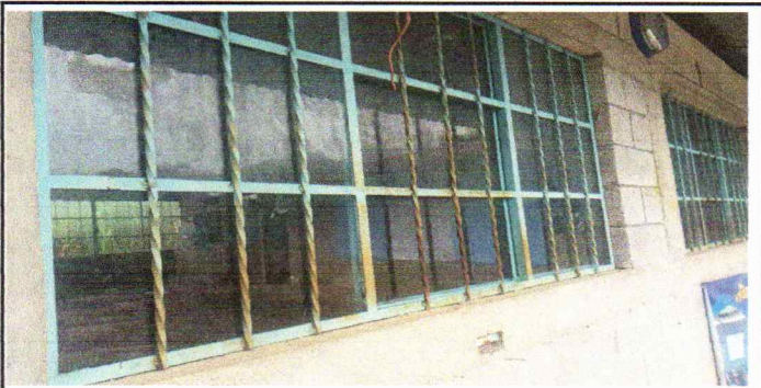
Foto 5: Sustitución de vidrios.
