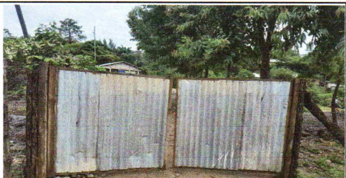
Foto 6: Sustitución de un portón.
