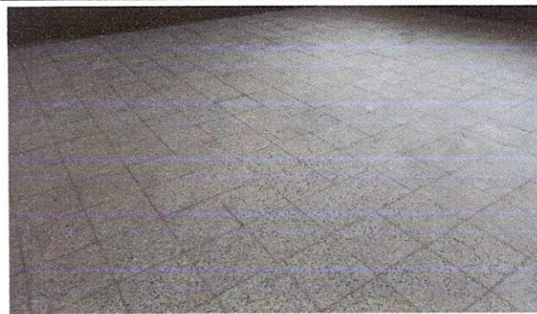
Foto 2: Mejoramiento de piso de aulas finalizado.
