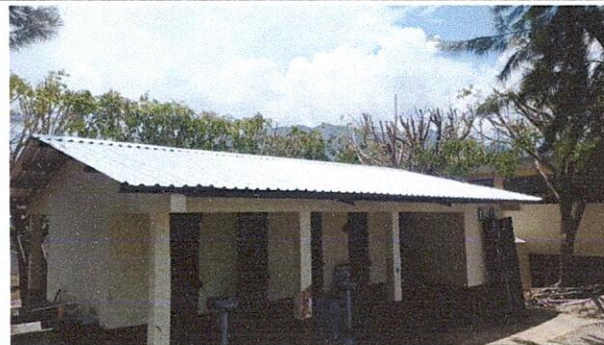
Foto 2: Cambio de láminas en techo de baños finalizado.
