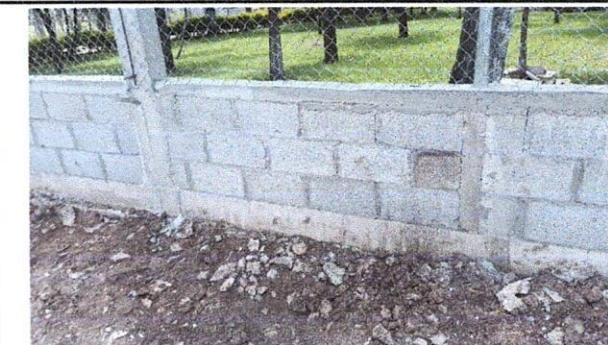
Foto 6: Mejoramiento de circulación perimetral finalizado.
