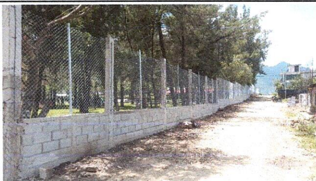
Foto 1: Mejoramiento de circulación perimetral finalizado.
