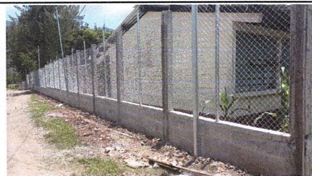
Foto 3: Mejoramiento de circulación perimetral finalizado.
