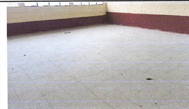
Foto 6: Mejoramiento de piso de aulas finalizado.
