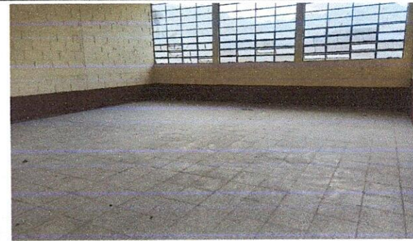
Foto 4: Mejoramiento de piso de aulas finalizado.
