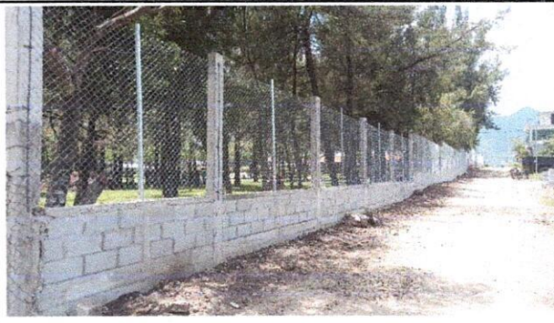
Foto 2: Mejoramiento de circulación perimetral finalizado.
