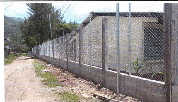
Foto 4: Mejoramiento de circulación perimetral finalizado.
