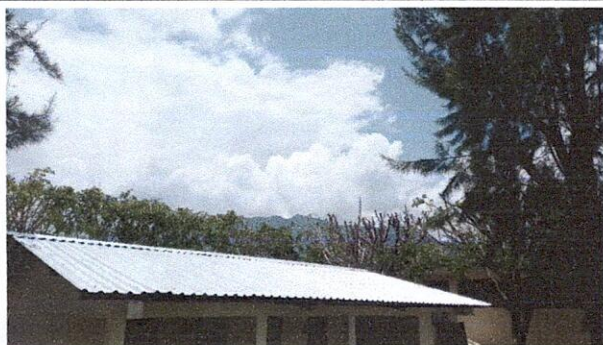
Foto1: Cambio de láminas en techo de baños finalizado.
