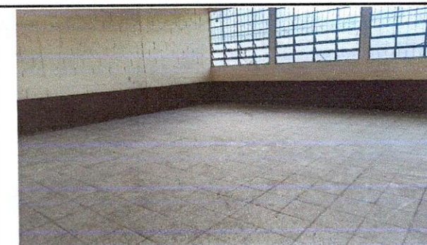
Foto 5: Mejoramiento de piso de aulas finalizado.
