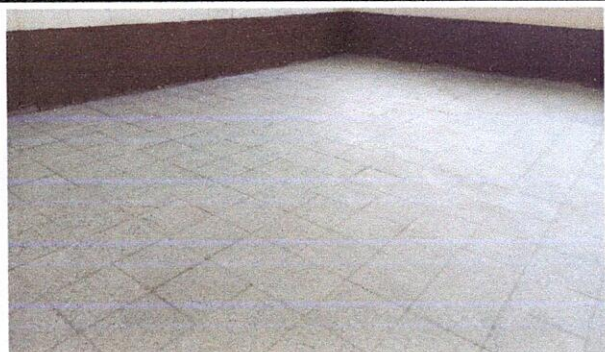
Foto1: Mejoramiento de piso de aulas finalizado.
