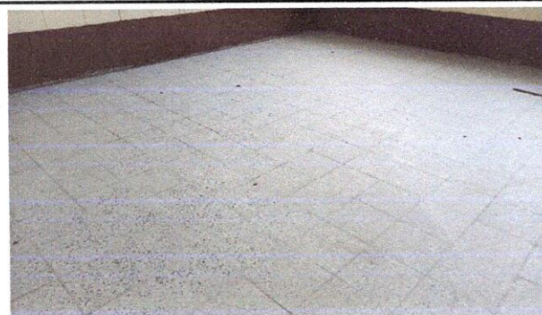
Foto 3: Mejoramiento de piso de aulas finalizado.
