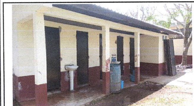
Foto 3: Mantenimiento a puertas de sanitarios para señoritas finalizado.
