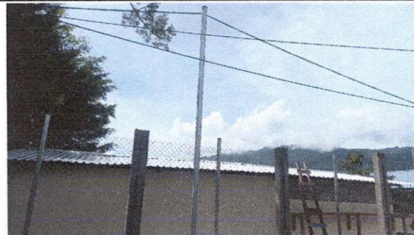
Foto 6: Cambio de láminas en techo de bodega finalizado.
