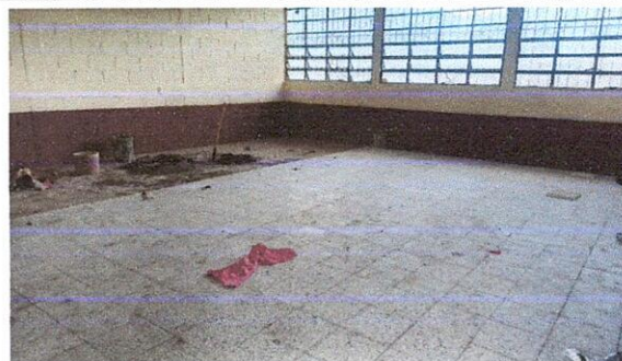
Foto 4: Mejoramiento de piso de aulas en proceso.
