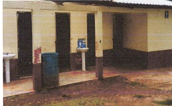
Foto 2: Mantenimiento y cambio a puertas de baños en proceso.
