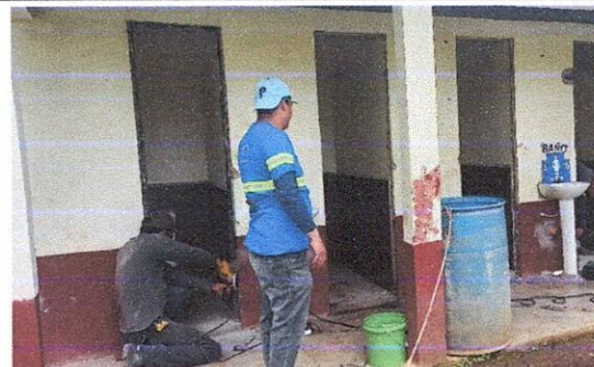
Foto 6: Mantenimiento y cambio a puertas de baños en proceso.
