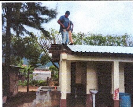
Foto1: Cambio de láminas de techo de baños y bodega en proceso.
