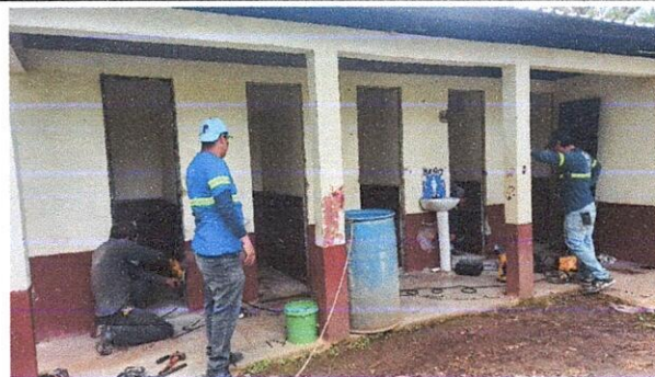
Foto 4: Mantenimiento y cambio a puertas de baños en proceso.
