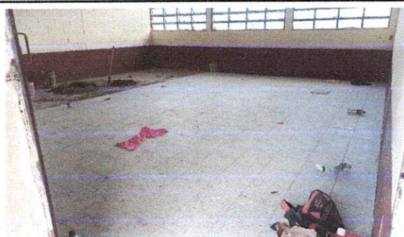
Foto 5: Mejoramiento de piso de aulas en proceso.
