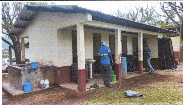
Foto 3: Mantenimiento y cambio a puertas de baños en proceso.
