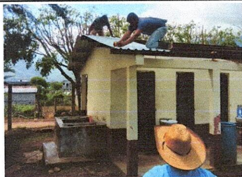
Foto 3: Cambio de láminas de techo de baños y bodega en proceso.
