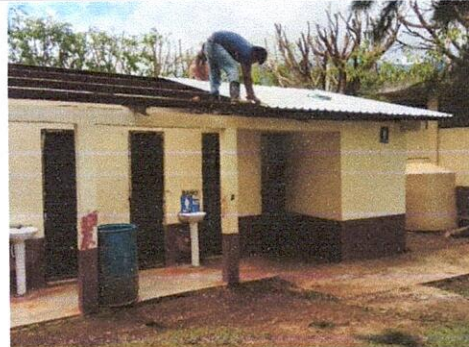
Foto 4: Cambio de láminas de techo de baños y bodega en proceso.
