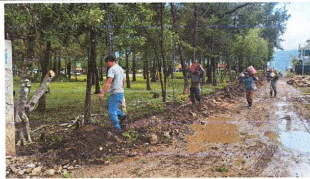
Foto 2: Mejoramiento de circulación perimetral en proceso.
