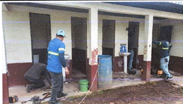
Foto 5: Mantenimiento y cambio a puertas de baños en proceso.
