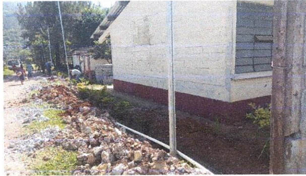
Foto 4: Mejoramiento de circulación perimetral en proceso.
