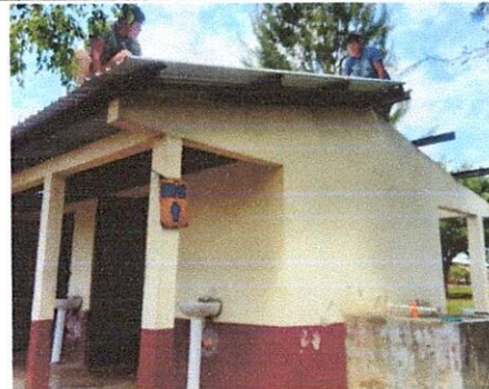
Foto 2: Cambio de láminas de techo de baños y bodega en proceso.
