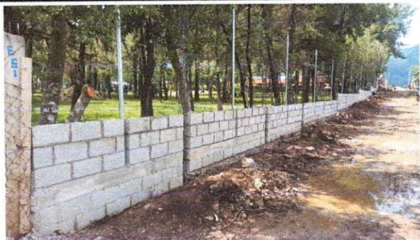
Foto 3: Mejoramiento de circulación perimetral en proceso.
