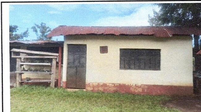
Foto 5: Cubierta de lámina
