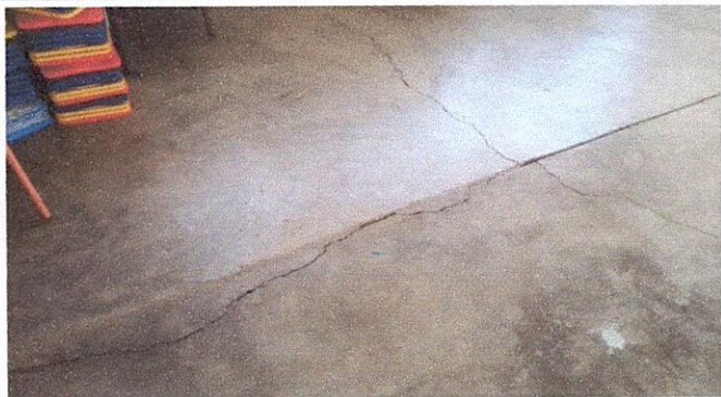
Foto 7: Sustrucción de Piso de aula
