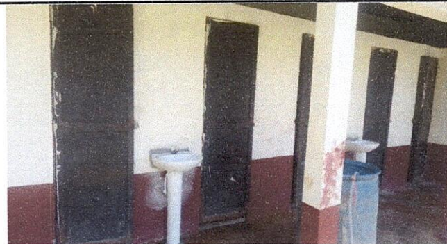
Foto 12: Mantenimiento a estructura de puertas de baños
