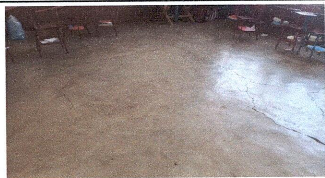
Foto 9: Sustrucción de piso de aula
