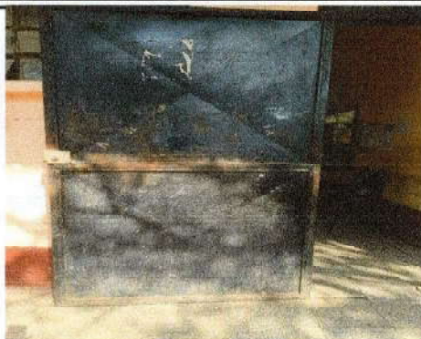
Foto 1: Reparación de puertas
