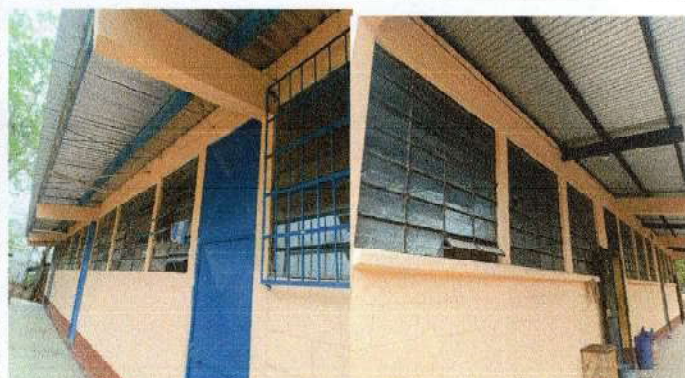
Foto 3: Sustitución de balcones
