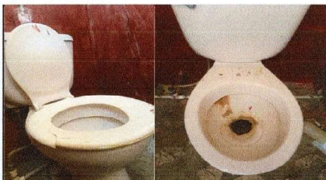
Foto 4: Sustitución de sanitarios
