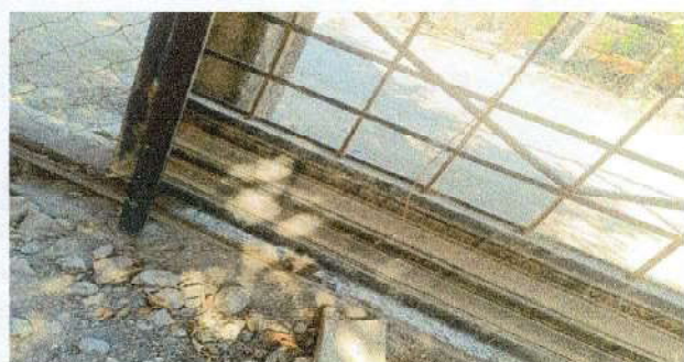
Foto 5: Reparación de portón
