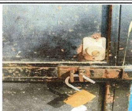
Foto 2: Sustitución de chapas
