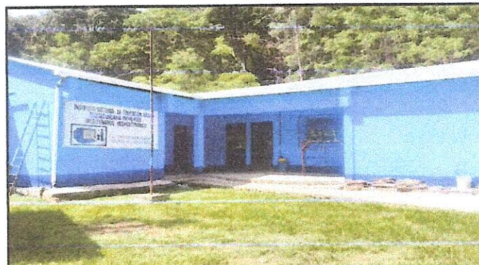
Foto 4: Pintura en muros exteriores e interiores
