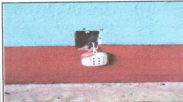
Foto 3: REPARACION DE SISTEMA ELÉCTRICO (cambio de cableado, focos, plafoneras, interruptores, tomacorrientes, flípones)
