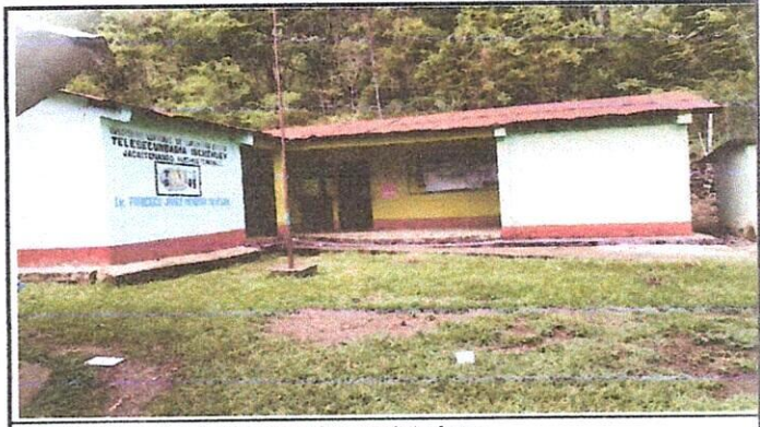
Foto 4: Pintura en muros exteriores e interiores
