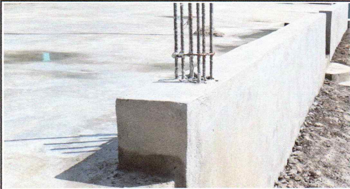
Foto 3: Reparación de muro
