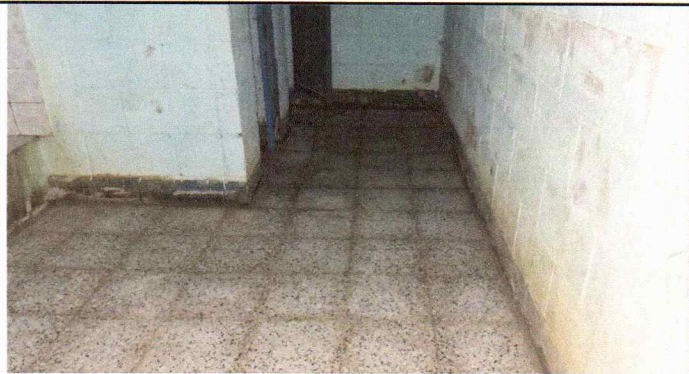
Foto 2: Sustitución de piso de granito
