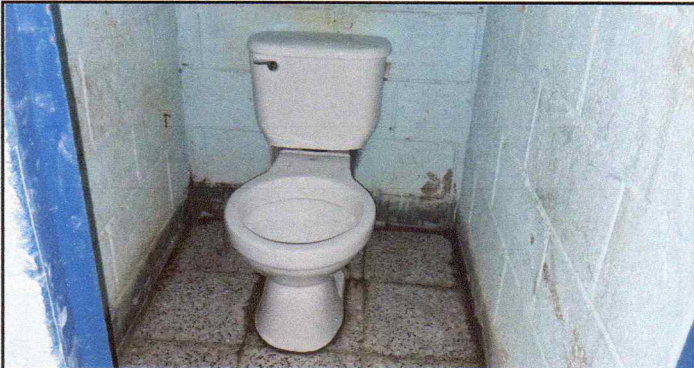
Foto 4: Sustitución de inodoro
