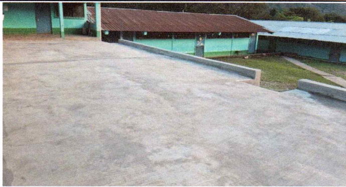
Foto1: Sustitución de planchas de concreto de patio
