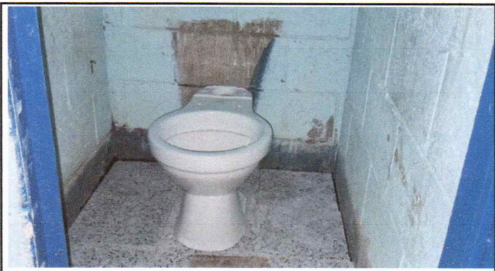
Foto 4: Sustitución de inodoro
