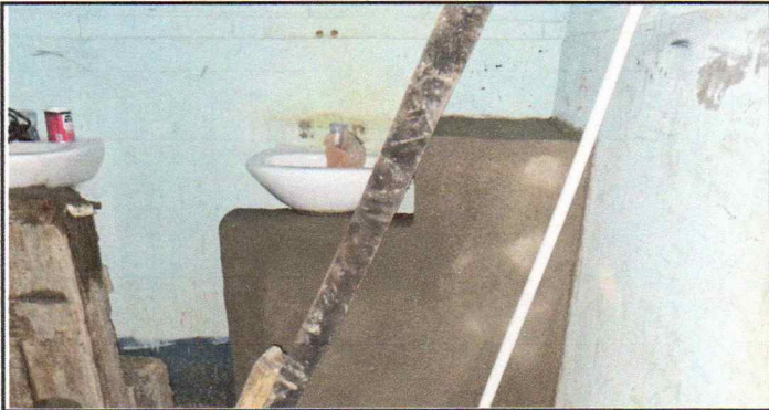
Foto 5: Sustitucion de lavamanos
