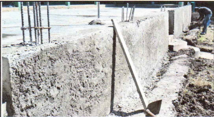
Foto 3: Reparación de muro
