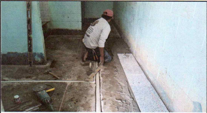
Foto 2: Sustitución de piso de granito
