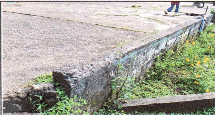
Foto 3: Reparación de muro
