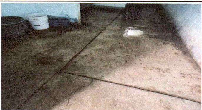
Foto 2: Sustitución de piso de granito
