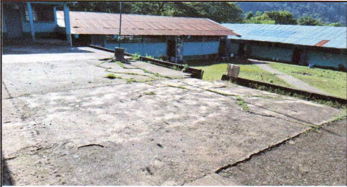
Foto1: Sustitución de planchas de concreto de patio
