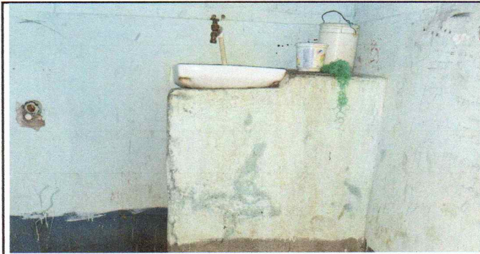
Foto 5: Sustitucion de lavamanos
