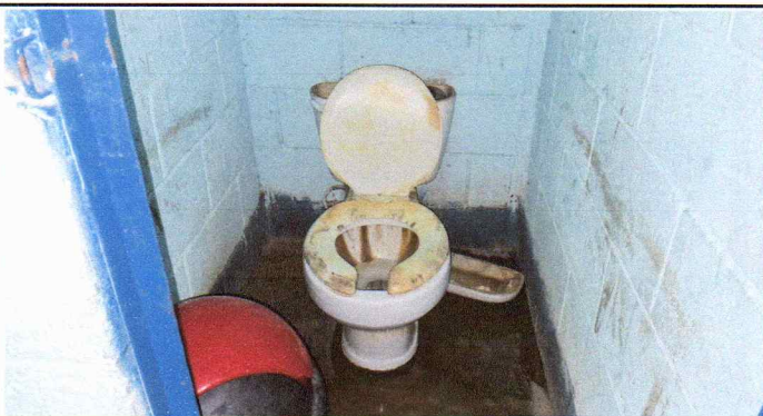
Foto 4: Sustitución de inodoro
