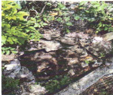
Foto 6: Caja de registro en mal estado.
