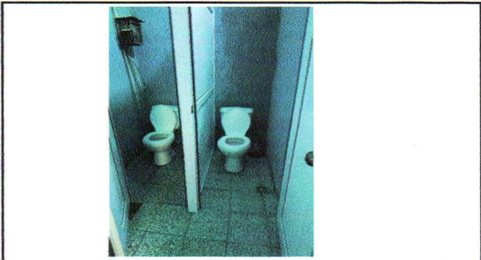
Foto 2: Sustitución de inodoros
