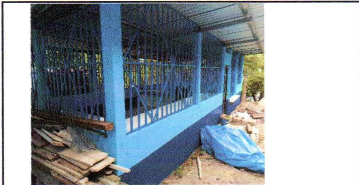
Foto 5: Sustitución de balcones de metal
