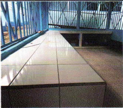
Foto 10: Sustitución de azulejo en muebles de cocina.
