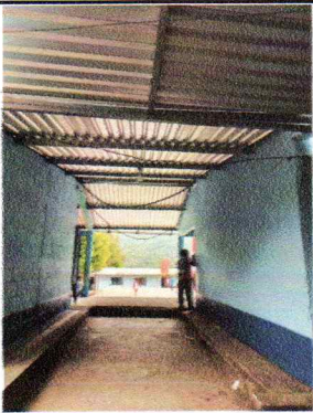
Foto7: Sustitución de estructura de madera por metal
