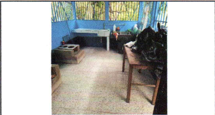
Foto1: Sustitución de piso de granito
