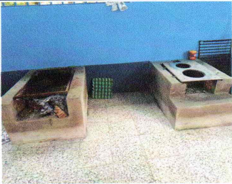
Foto 9: Sustitución de estufa rural incluye chimenea y plancha de metal
