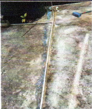
Foto 11: Impermeabilización de losa
