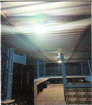
Foto 12: Reparación del sistema eléctrico
