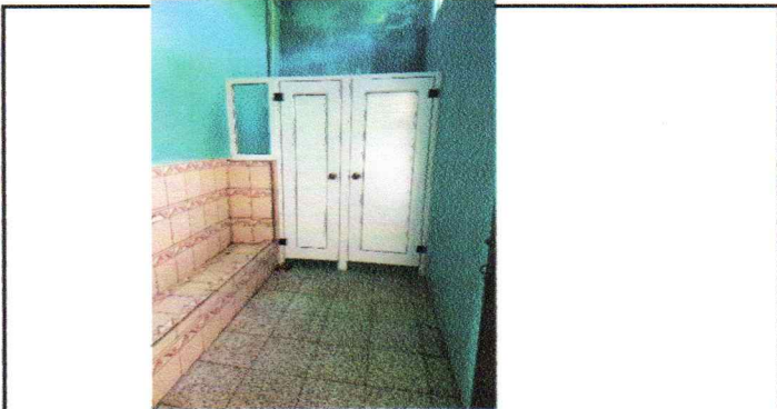
Foto 3: Sustitucion de puertas de servicios sanitarios de 1.80 m de alto por 0.70 m de ancho
