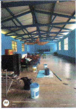
Foto 8: Pintura en muros de exteriores e interiores
