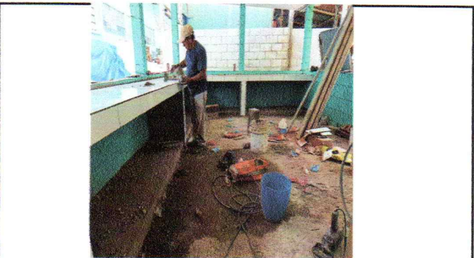
Foto 10: Sustitución de azulejo en muebles de cocina.
