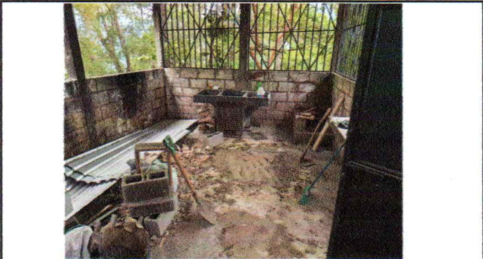
Foto1: Sustrucción de piso de granito
