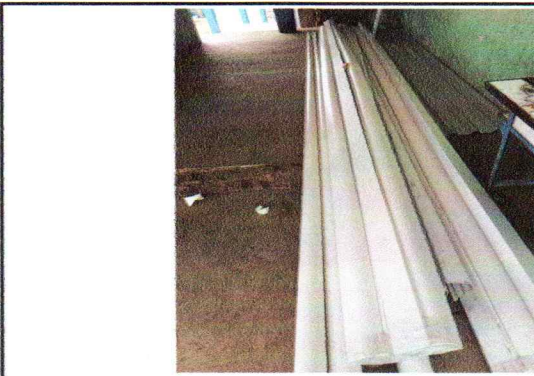
Foto 4: Canales y bajadas de agua pluvial
