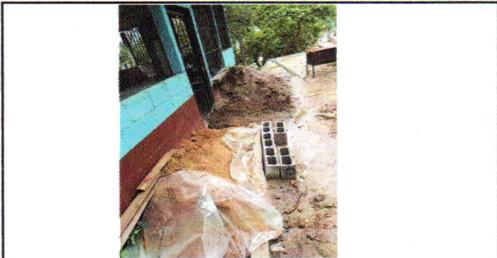
Foto 5: Sustrucción de balcones de metal
