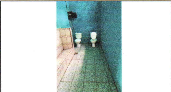
Foto 3: Sustrucción de puerta de servicios sanitarios de 1.80 m de alto por 0.70 m de ancho
