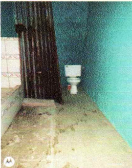
Foto 3: Sustitucion de puertas de servicio sanitario de 1.80 m de alto por 0.70 de ancho
