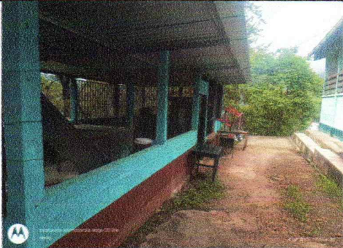
Foto 5: Sustitución de balcones de metal
