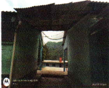
Foto 6: Sustitución de lámina, por lámina troquelada alizinc calibre 26
