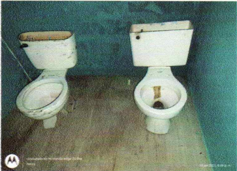
Foto 2: Sustitución de inodoros
